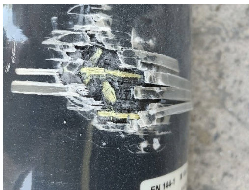
Przykładowe uszkodzenie poziomu 3 spowodowane delaminacją włókien powłoki konstrukcyjnej
